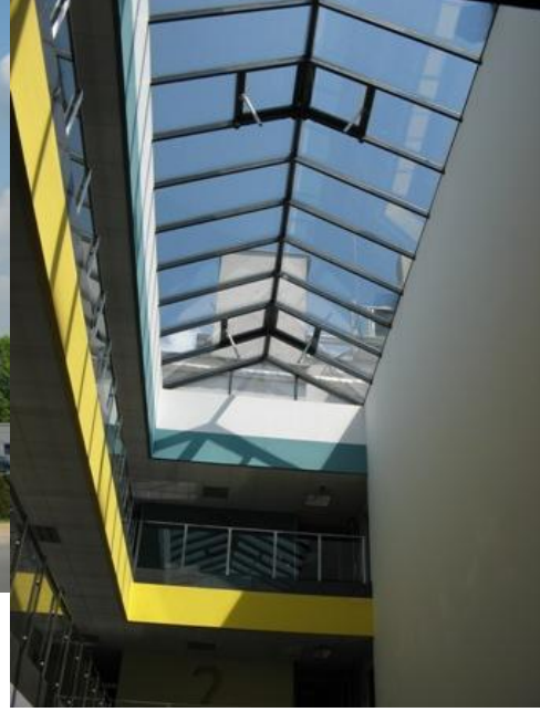
Euro-Centrum Enerji Tasarruflu Bina: Tavanın camla kaplı olması koridor aydınlatmasını sağlamaktadır.
